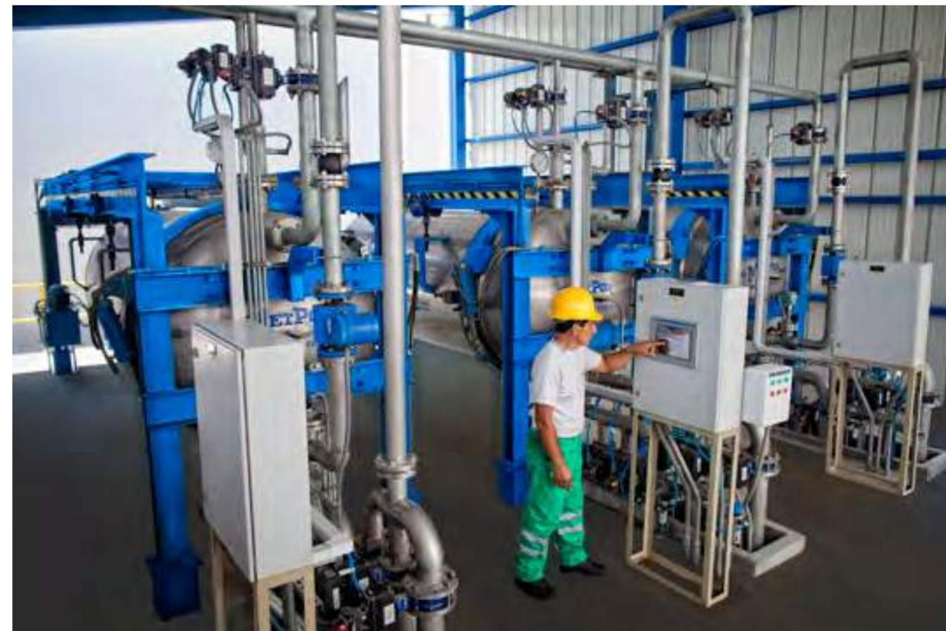
Filtros de flujo horizontal en la nueva refinería de azúcar.
