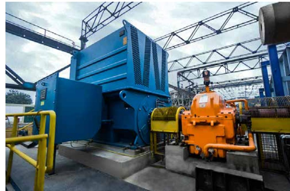
Cambio de turbina de vapor a motor eléctrico en el desfibrador de caña.
